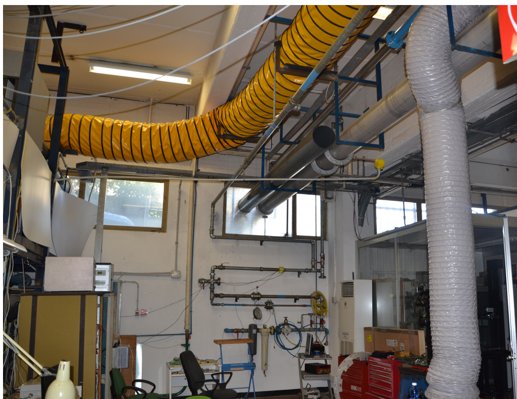
FIGURA 2.1: Vista generale del laboratorio, si possono vedere il sistema di aspirazione (in giallo) e la linea secondaria (sulla parete in fondo.)
